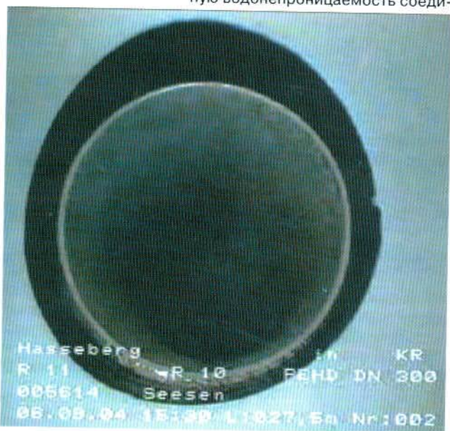
Рис. 14. Снимок подключения к локальной сети, вид из канализационного коллектора, полученный в ходе технического осмотра, производившегося с использованием видеокамеры.
