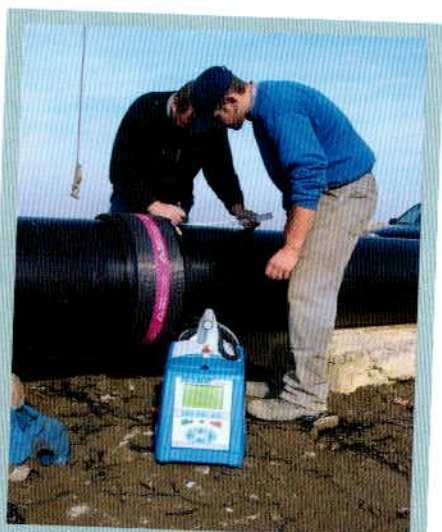
Рис. 6. Соединение двух полиэтиленовых труб методом электромуфтовой сварки.
