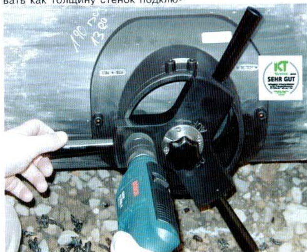
Рис. 12. Засверловка подключения патрубка-накладки ASA-TL, входящего в состав трубопроводной монтажной системы, посредством устройства для врезки FWFIT.
