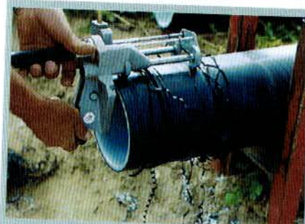
Рис. 8. Подготовка свариваемых поверхностей, состоящая в снятии стружки до полного удаления оксидного слоя
